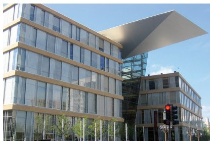
Verejná knižnica v Minneapolise – exteriér
