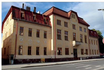
Budova knižnice pred rekonštrukciou
