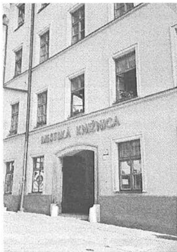
Obr. 1 Budova Mestskej knižnice v Bratislave
