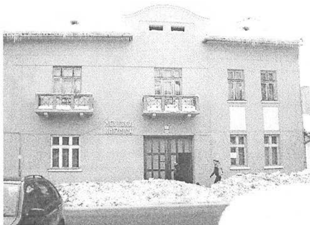
Budova Mestskej knižnice v Brezne
