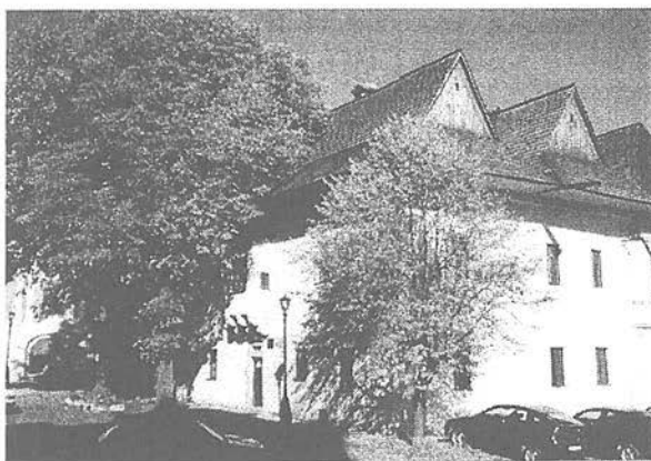
Budova knižnice v Spišskej Sobote
